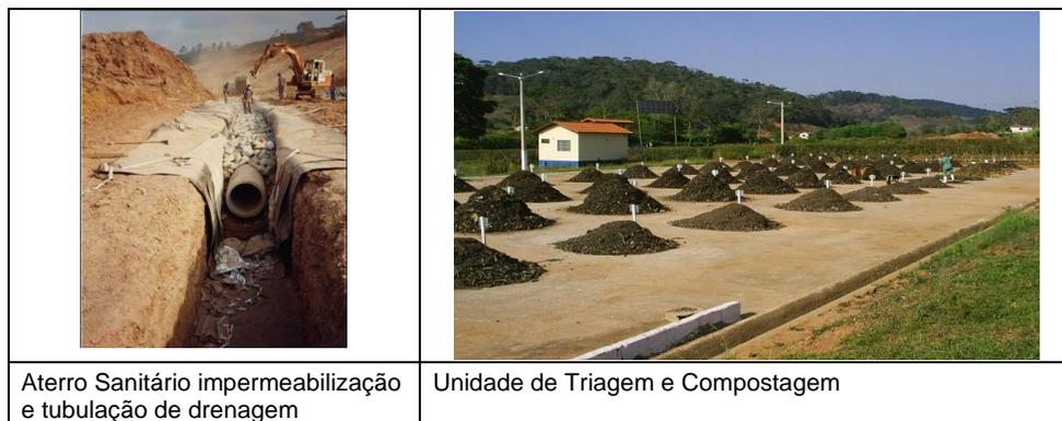
Figura 22 – Detalhes de construção de um aterro sanitário e unidade de triagem e compostagem.
