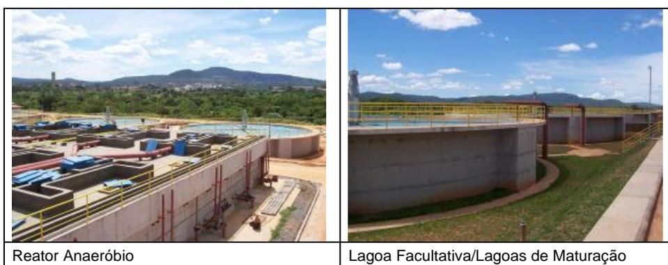
Figura 21 – Estação de Tratamento de Esgotos de Montes Claros (Fonte: COPASA)
